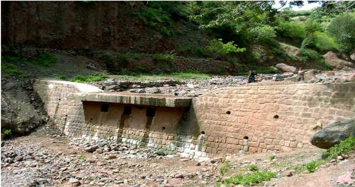
*Photo 2 : Seuil édifié sur l'affluent Tighzrit et comblé par la charge solide des crues*
