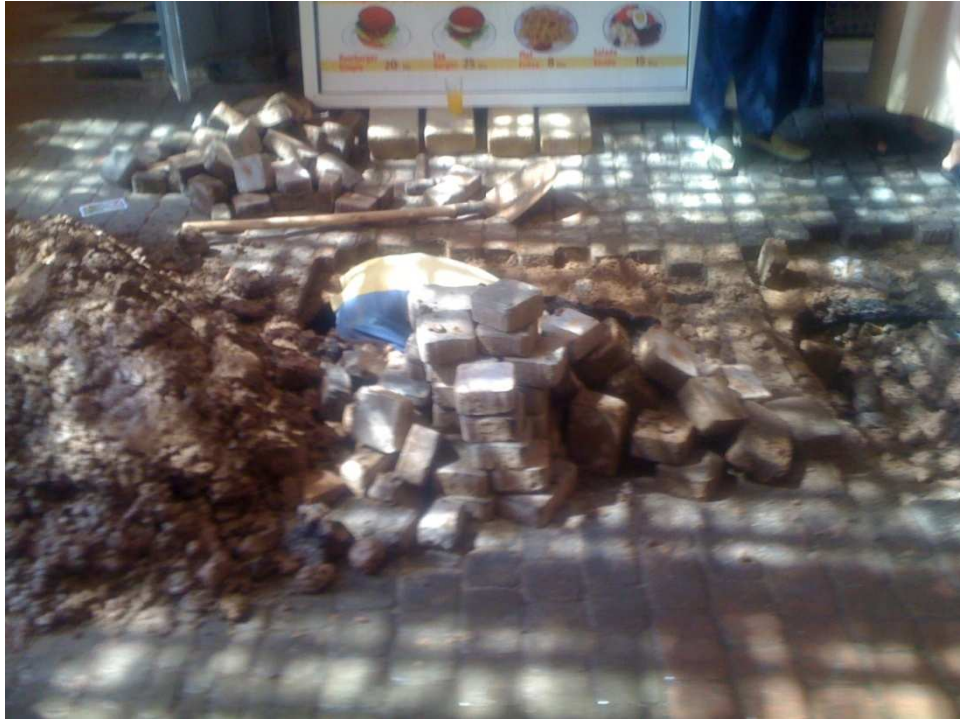
Photo 1 : * Creusement pour detection de la fuite *Lieu : ancienne médina
