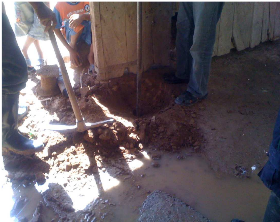
Photo3 : *Creusemnt pour détecction de la bouche à clé * Lieu : Douar SAADNA
