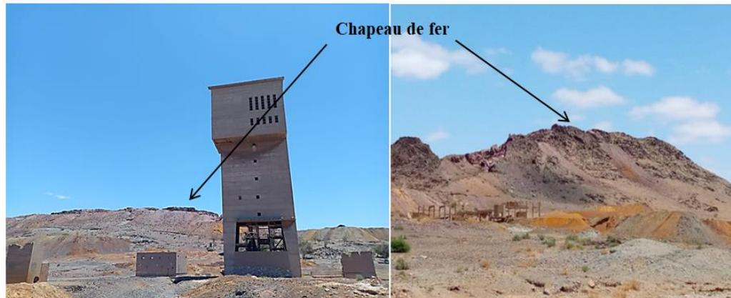
**Figure 13 - Photo du chapeau de fer au niveau de la mine Kettara.**
