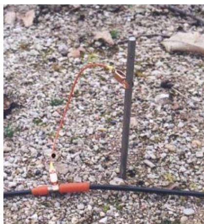
Photo III.7 : Electrode, Connecteur et le Câble de mesure
