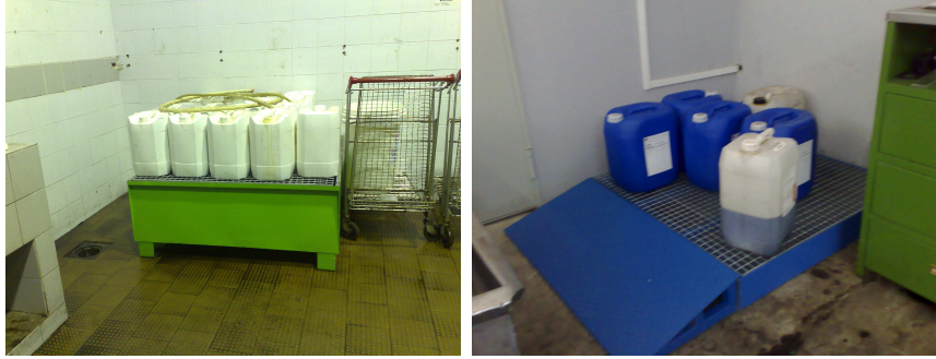
Fig. 55 : Bacs de rétention implantés dans la cuisine des additifs..
