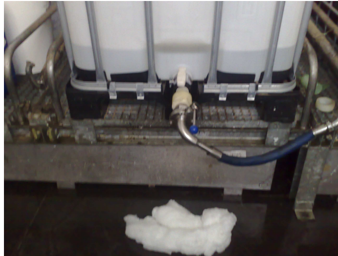
Fig. 58 : Utilisation de la mèche d'acétate comme absorbant sous les robinets à GRV.
