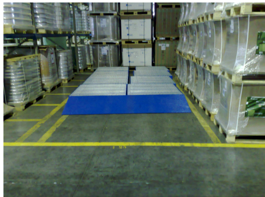
Fig. 57 : Plateforme de rétention dans le magasin de matières premières.
