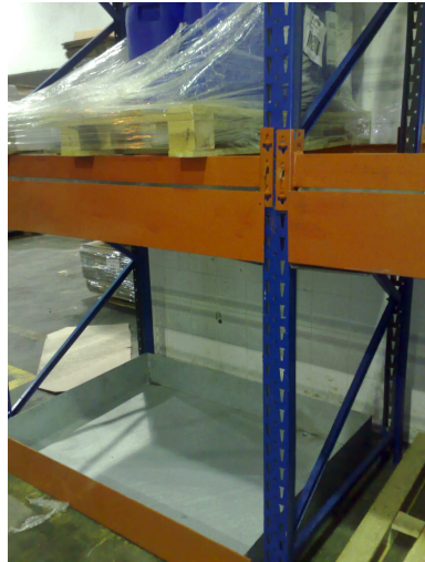
Fig. 56 : Rayonnage à rétention implanté dans le magasin tampon.
