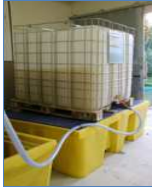
Fig. 13 : stockage des produits liquides sur les bacs de rétention (en jaune).
