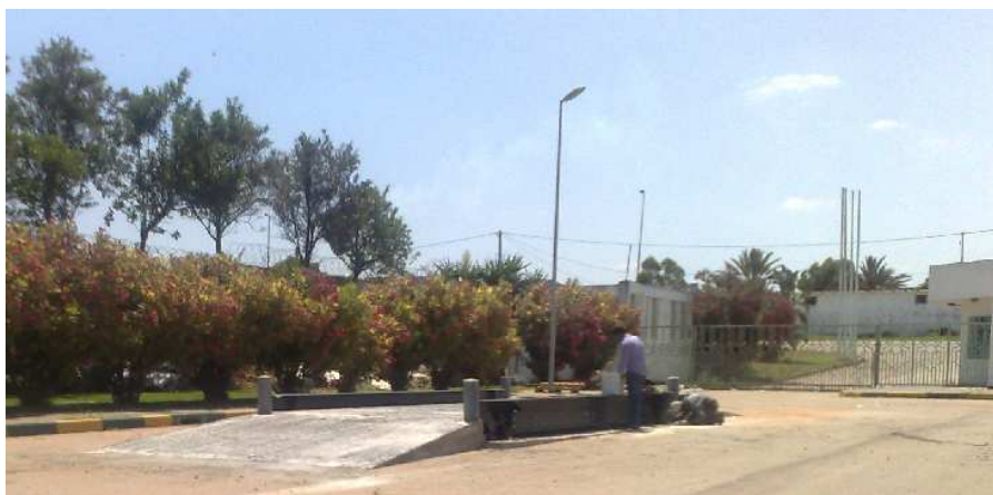
Fig. 60 : Pont bascule en cour de construction.
