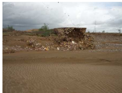
Figure 21 : Photo montrant la rupture des cages de gabions du seuil Bahsia
