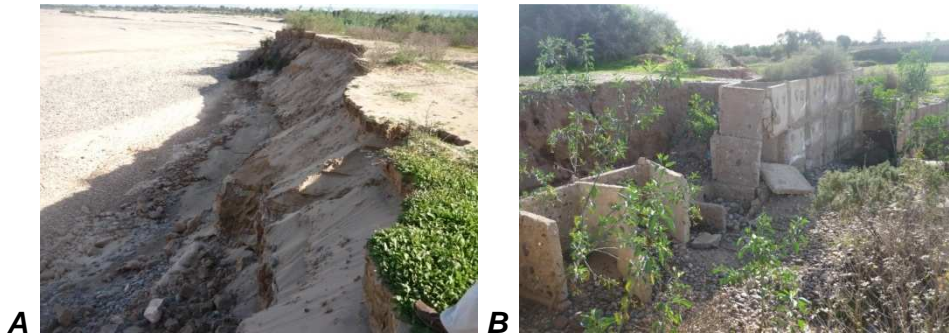
Figure 18 : Photos montrant dégâts au niveau du Seuil Freija aval
