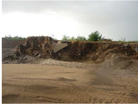
Figure 23 : Photo montrant les restes des gabions dans la rive gauche du Seuil Lalla Tamsist
