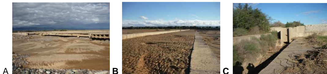
Figure 17: Photos montrant dégâts au niveau du Seuil Freija amont
