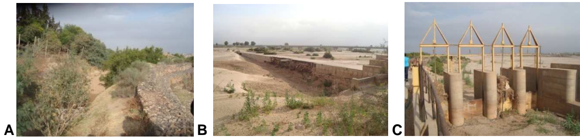
Figure 20 : Photos montrant l'état du Seuil Souiguia
