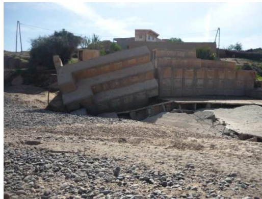
Figure 19 : Photo montrant l'effondrement au niveau de la rive gauche du Seuil Sidi Amara
