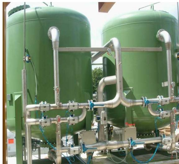
Figure 22: schéma et photo de filtres à sable
