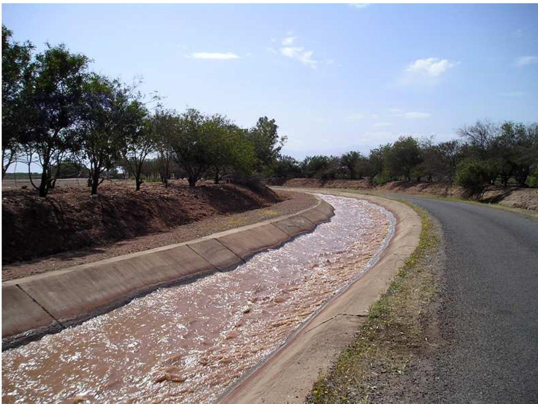
Figure 7 : canal de dérivation des eaux de la Rocade vers le bassin 520
