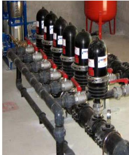
Figure 21: schéma et photo du filtre à disques
