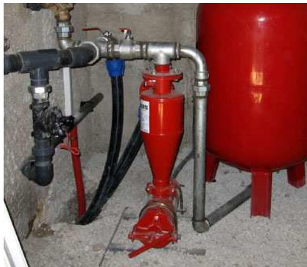
Figure 20 : schéma et photo de l'hydrocyclone
