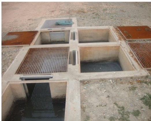
Photo.1 :Les différents regards de la STEP
