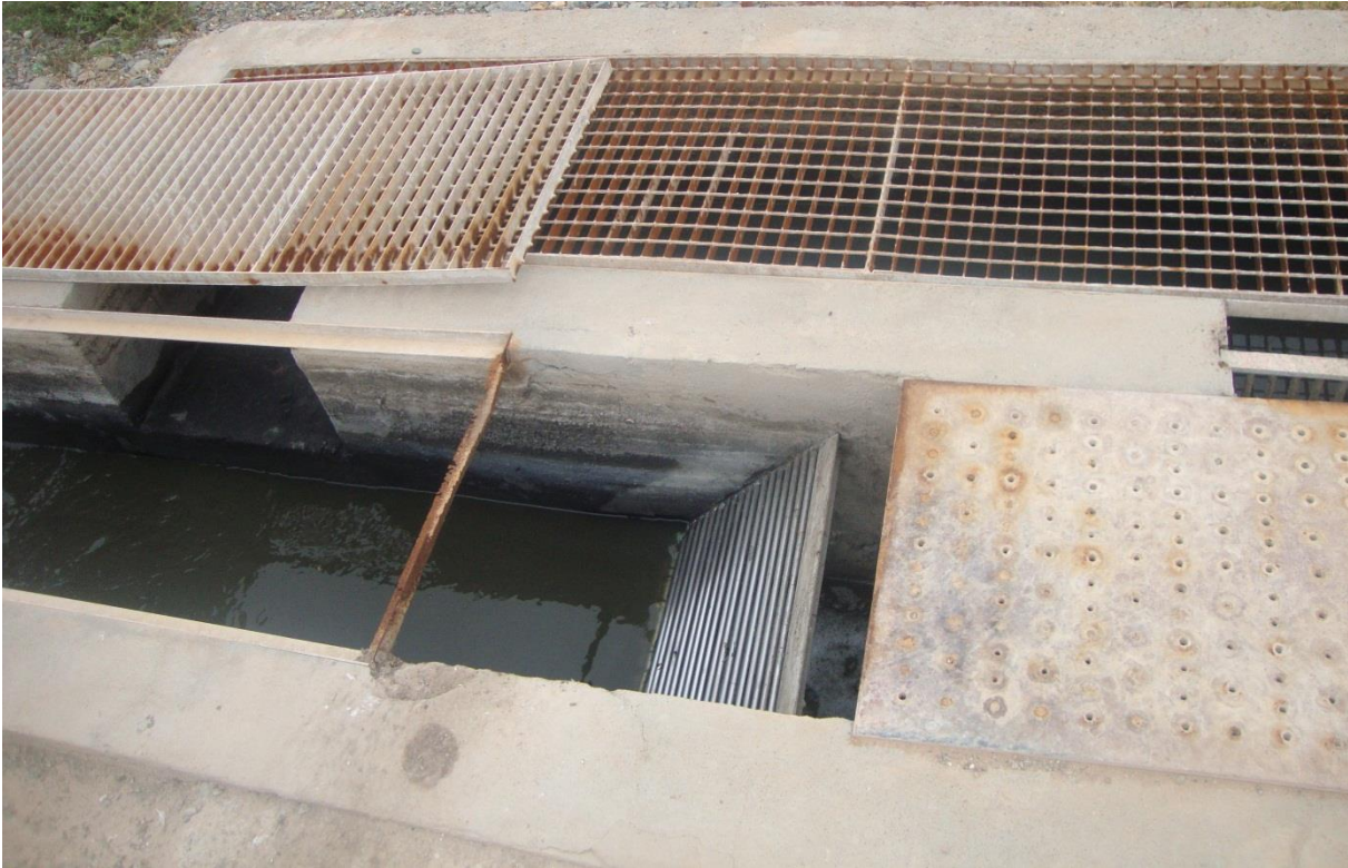
Fig.13:Type de dégrilleur utilisé dans la STEP de Chichaoua.
