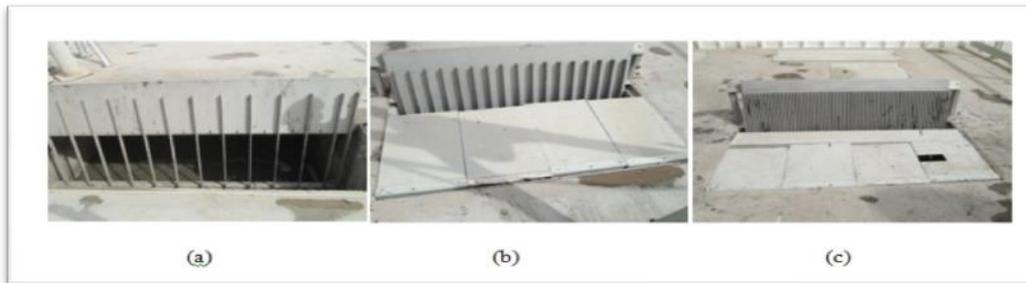
Figure 10 : a) Pré grille (20 cm)    b) Dégrilleur grossier (8cm)    c) Dégrilleur fin (1cm)
