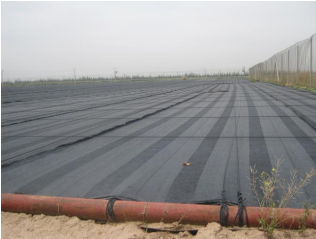
Phot. 3: Bassin couvert de décantation des eaux.
