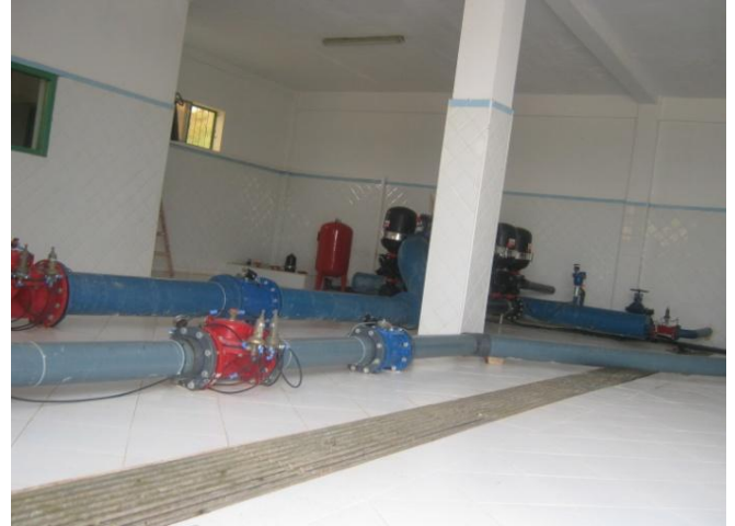
Phot. 2 : Equipements de pompage et de filtrage d'eau du bassin.
