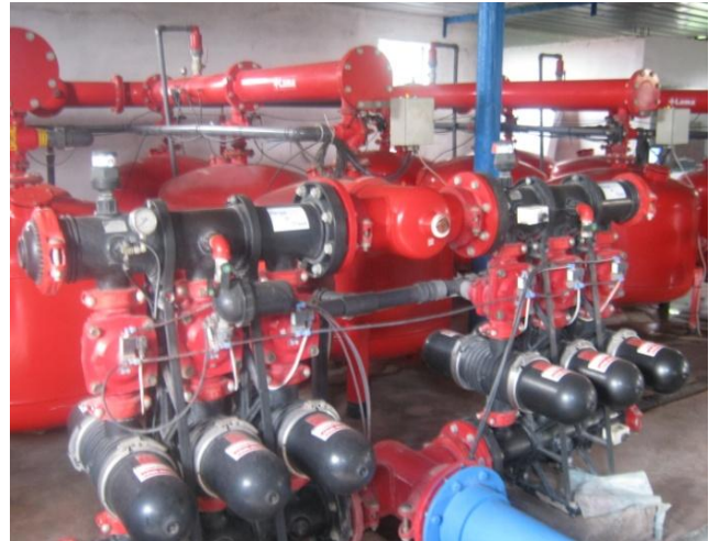
Phot.4 : Equipement de pompage d'eau.
