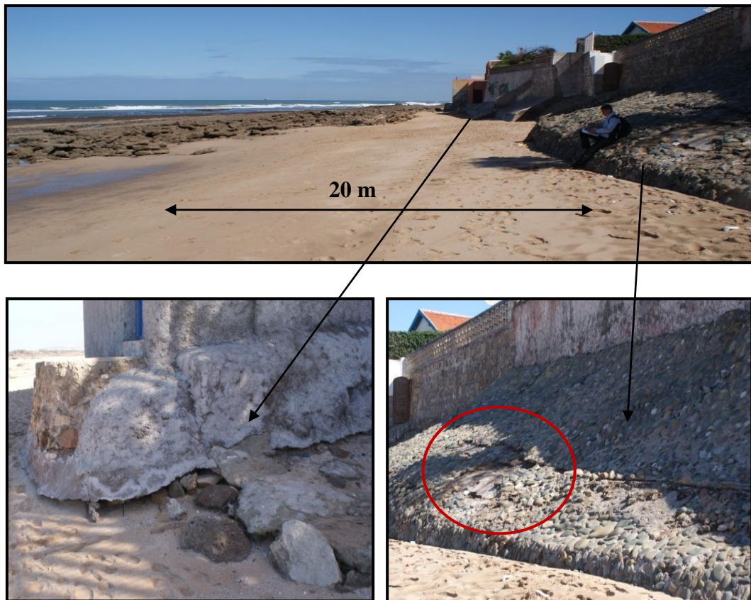
Figure VII. 1 : Influence de la houle sur les constructions et les murs de protection
