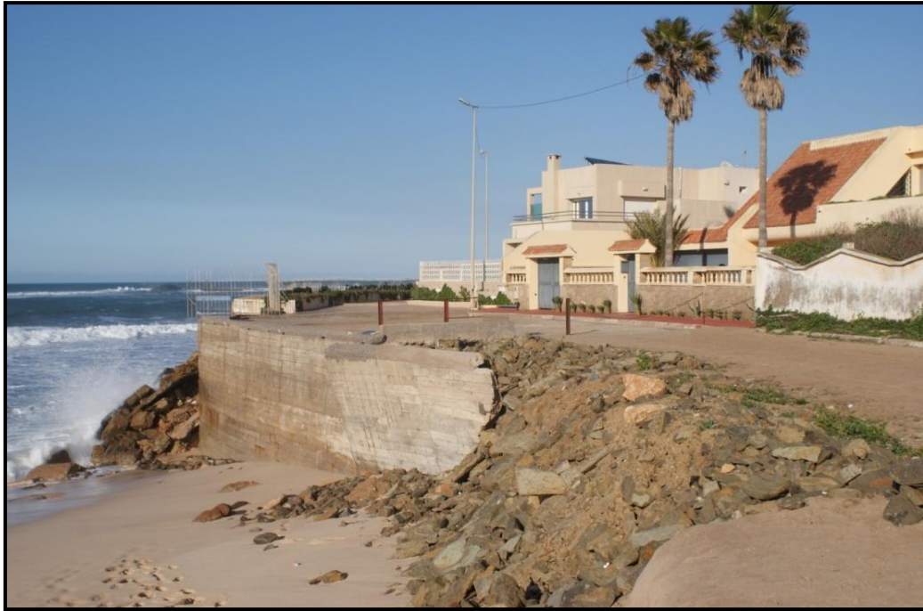
Figure VII. 3 : Mur dégradé suite aux actions des houles de vives eaux exceptionnelles
