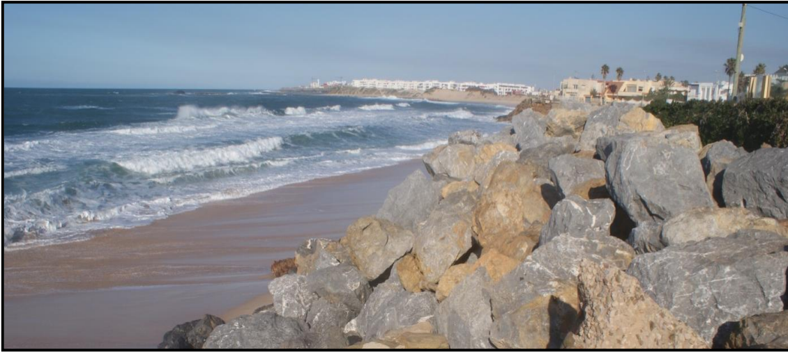
Figure VII. 5 : Blocs rocheux installés pour diminuer l'attaque frontale des houles
