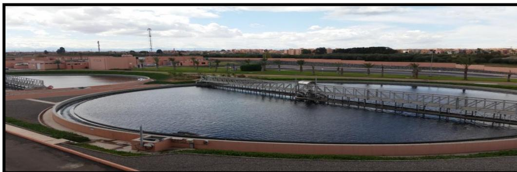
Photo 6: Le bassin de décantation secondaire « Clarificateur »
