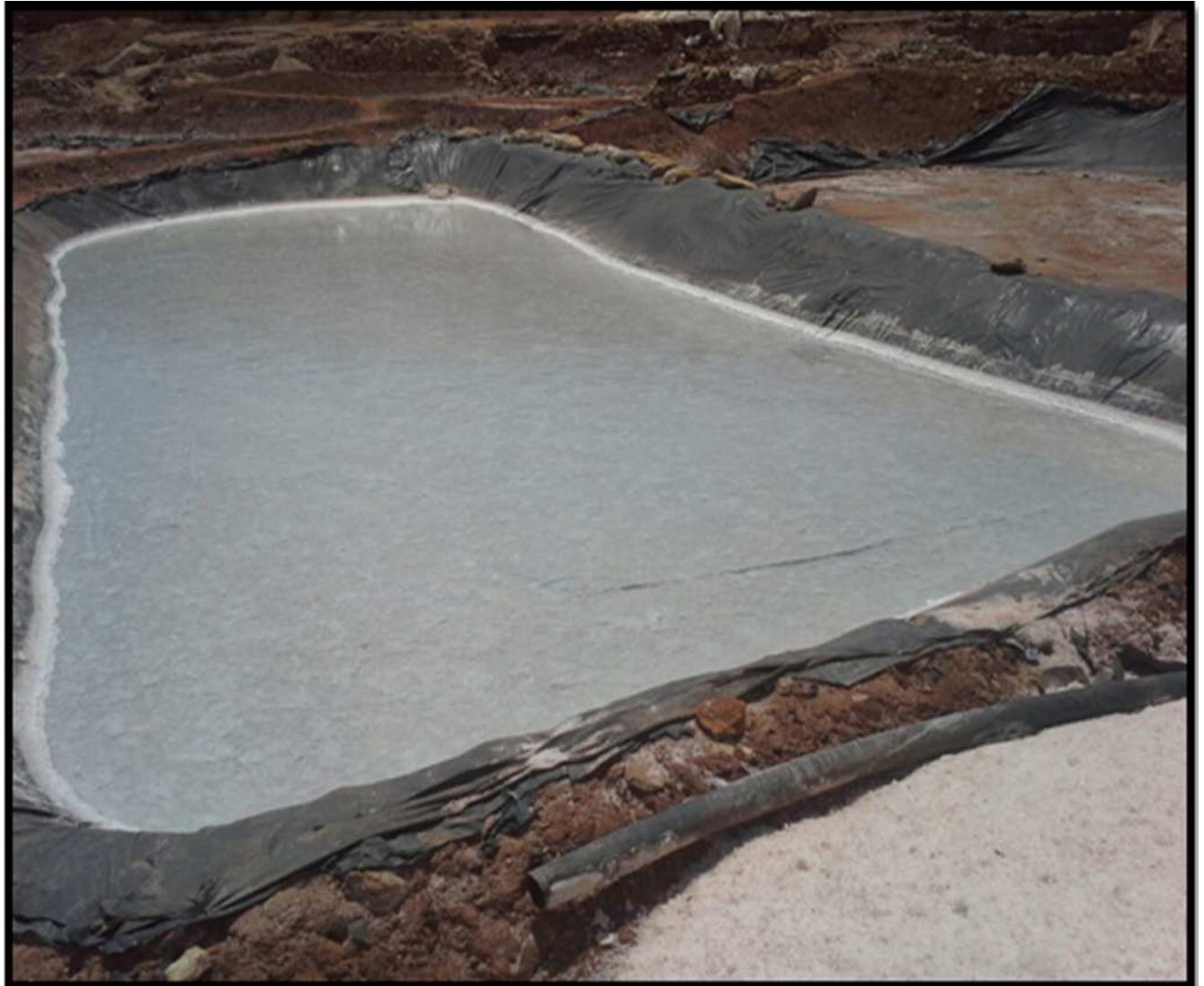
Photo 2 : Un bassin de décantation dans la région d'Ida Ouazza (05 Mai 2015).
