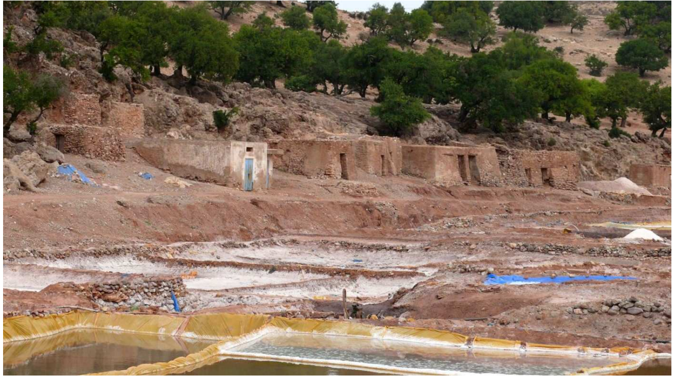
Photo 5 : Démolition de constructions à cause de l'affaissement du terrain (05 Mai 2015).
