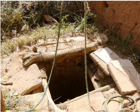
Photo n°1 : puits utilisé pour l'alimentation en eau potable (puits sans cuvelage)
