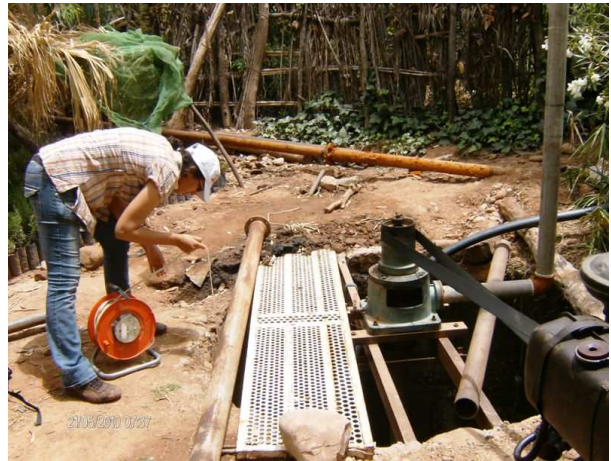
photo n°2 : puits utilisé pour l'irrigation avec pompe a axe vertical
