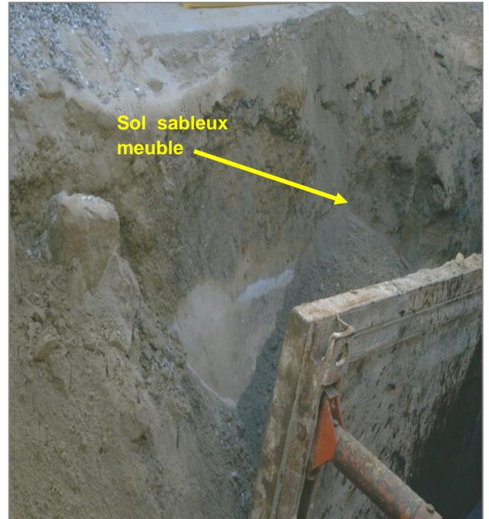
*Photo III.12 : Mise en place d'un système de blindage*
