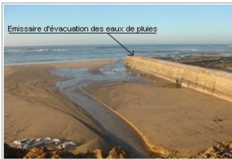
*Photo III.2: Emissaire d'évacuation des eaux pluviales*
