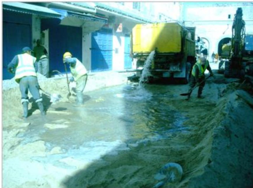
*c) compactage de la partie superficielle du remblai à l'aide de l'eau*
