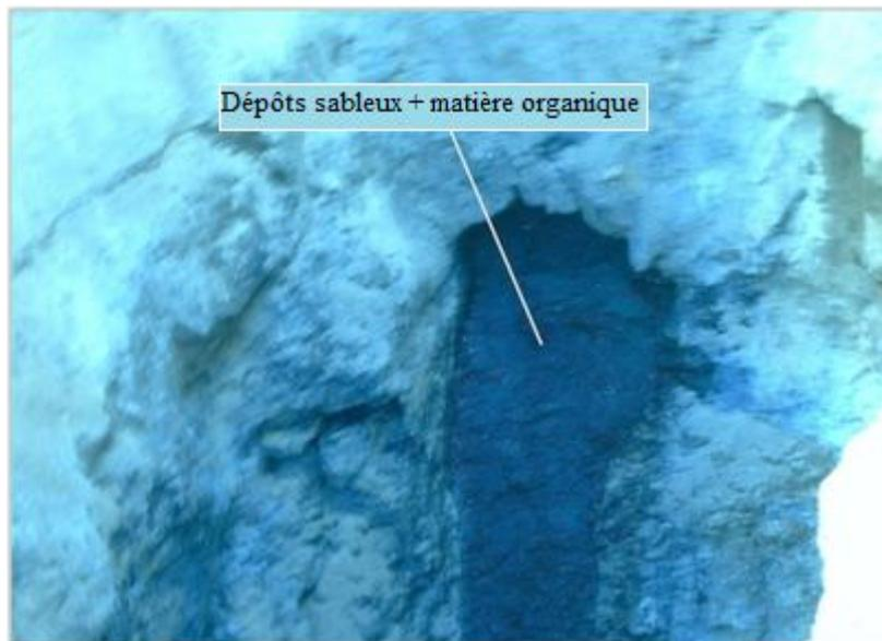
*Photo III.6 : Canal colmaté avec des dépôts noircis par la présence de la matière organique*
