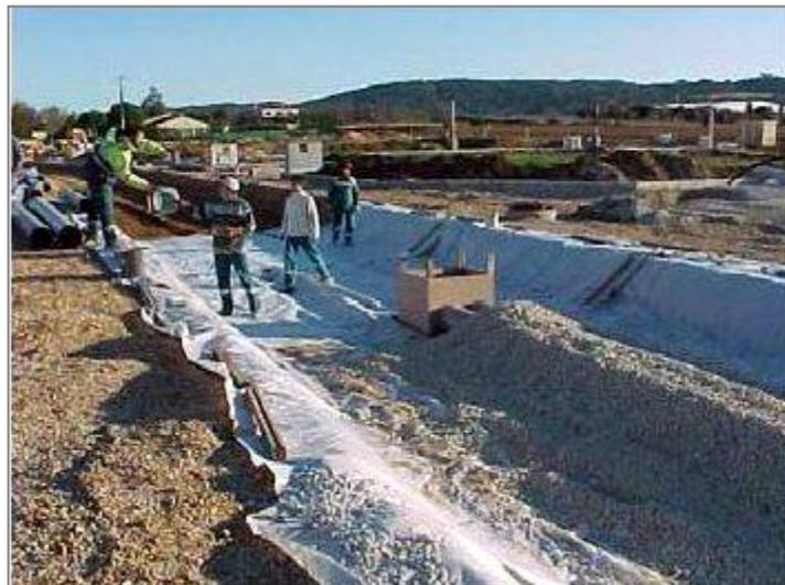
*Photo V.1 : la mise en place d'une chaussée à structure réservoir*
