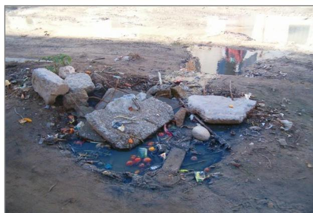
Photo III.7 : débordement des eaux usées suite à l'ensablement et colmatage des canaux
