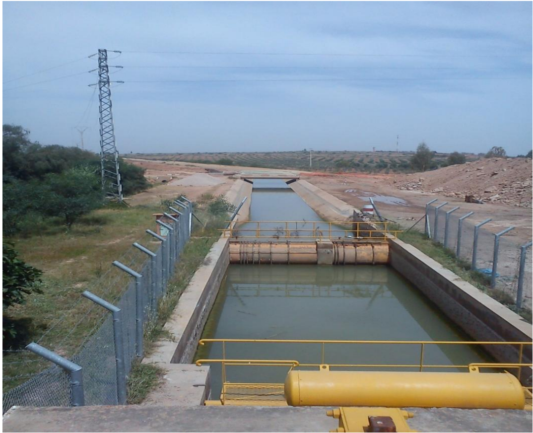
Fig.2 : Départ de A1 prise de canal T2 au PK 73.
