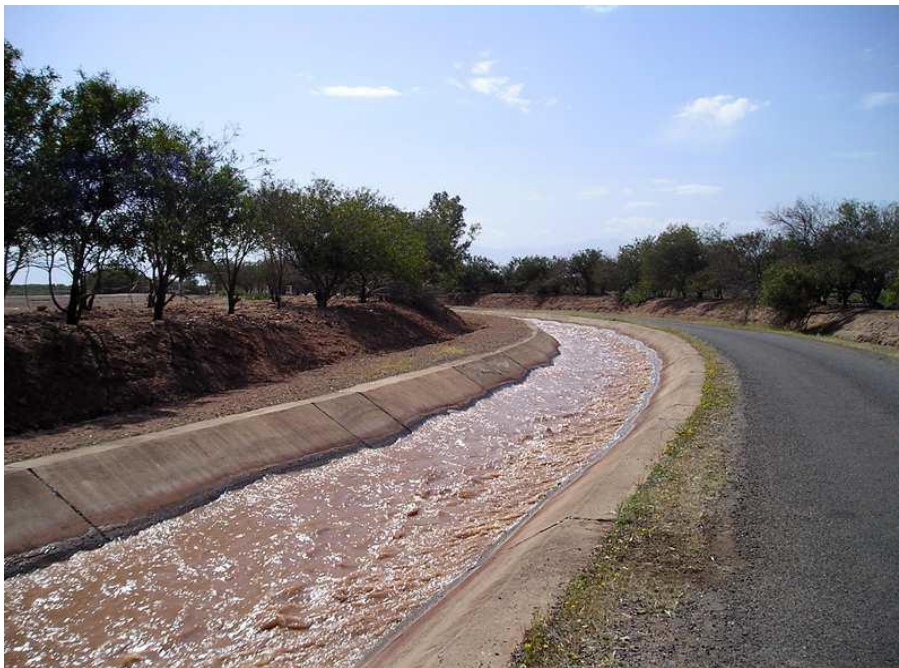
Figure 5: Canal de dérivation des eaux de la Rocade vers le bassin 520
