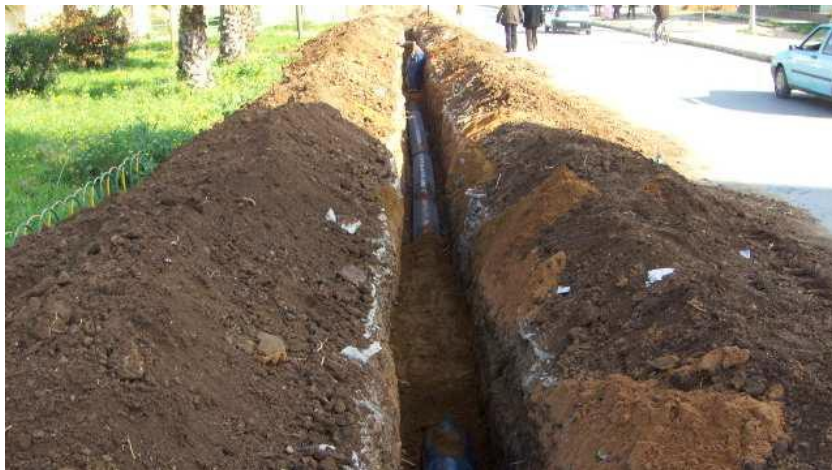
Photo 10 :Rehabilitation d'une conduite d'eau potable.
