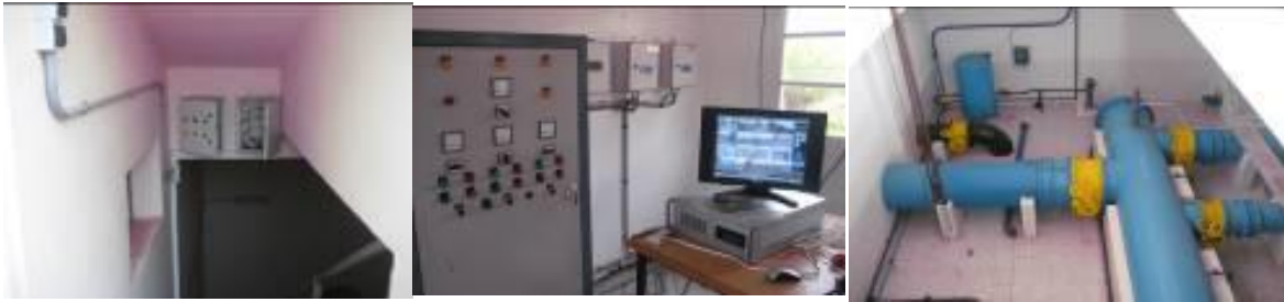
Photo 7, 8, 9 : Installation des piquages DN 40 sur Feeders.
