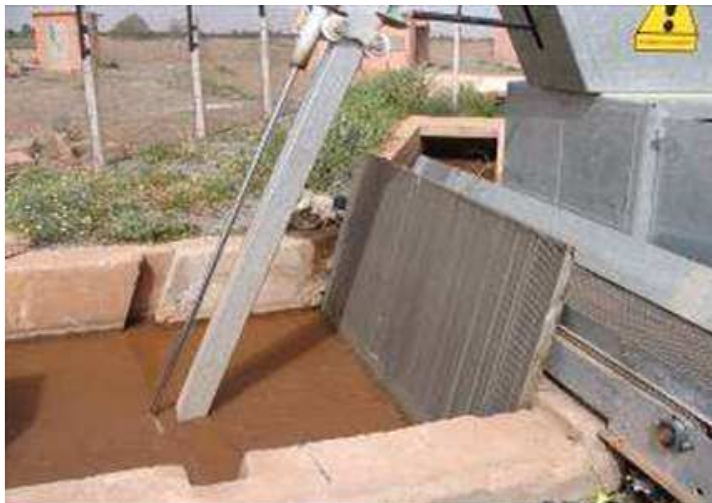
Photo 3 : Dégrilleur de la station Rocade (prise)
