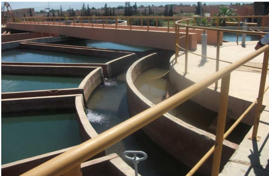
Figure 5: Décanteurs au niveau de la station Rocade (prise)
