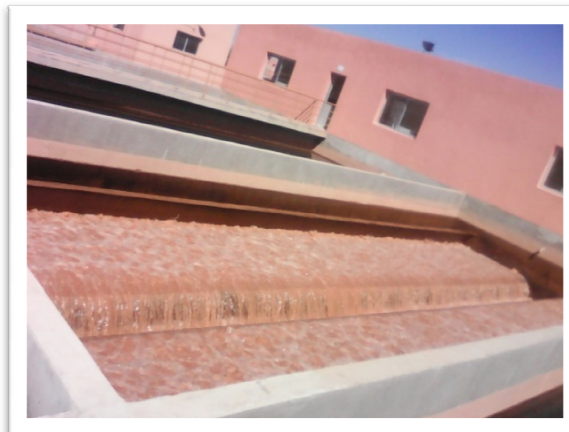
Photo 6 : Processus de filtration au niveau de la station Rocade (prise)
