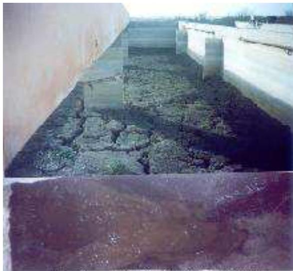
*Photo 7 : ancienne station d'épuration : traitement médiocre et mauvaise qualité des eaux à la sortie*
