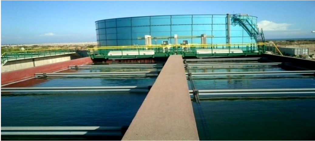
Figure 8 : Séparateur API et bac d'égalisation
