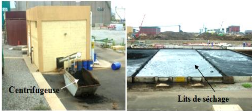
Figure 11: Centrifugeuse et lits de séchage
