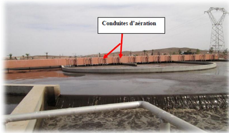
Figure 10 : Le bassin d'aération (ou bassin biologique)
