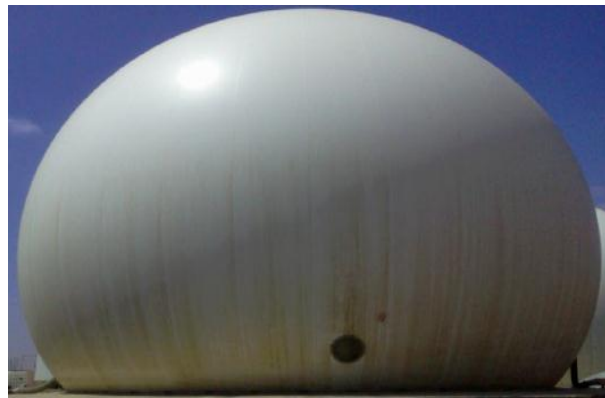
Figure 26 : Le stockeur de gaz (gazomètre)
