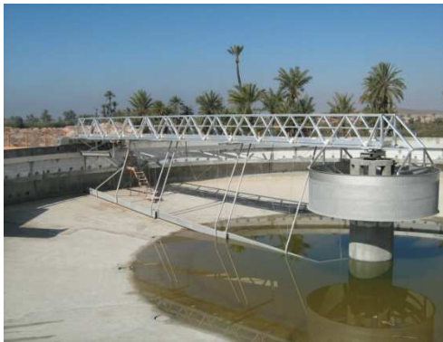
Photo 9 : Racleur du décanteur
