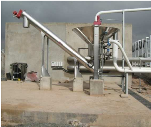
Photo 7 : Traitement des sables
