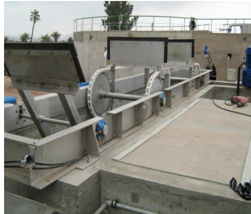
Photo 8 : Traitement des graisses
