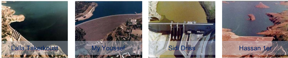
Figure 6: exemple d'ouvrages de la grande hydraulique
