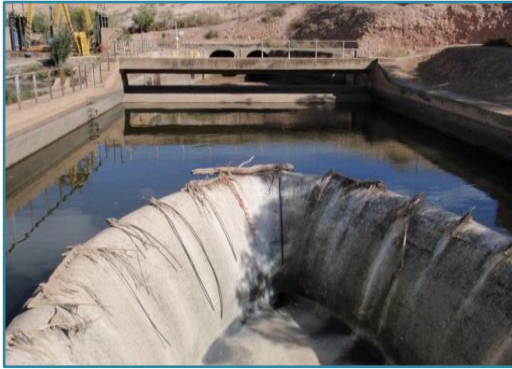
Figure 67: le puits de chute.
