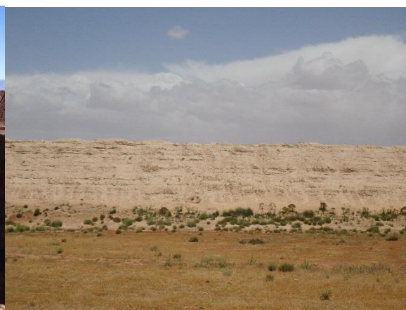
Photo. 5 : Résidus de traitement stockés dans des parcs à résidus
