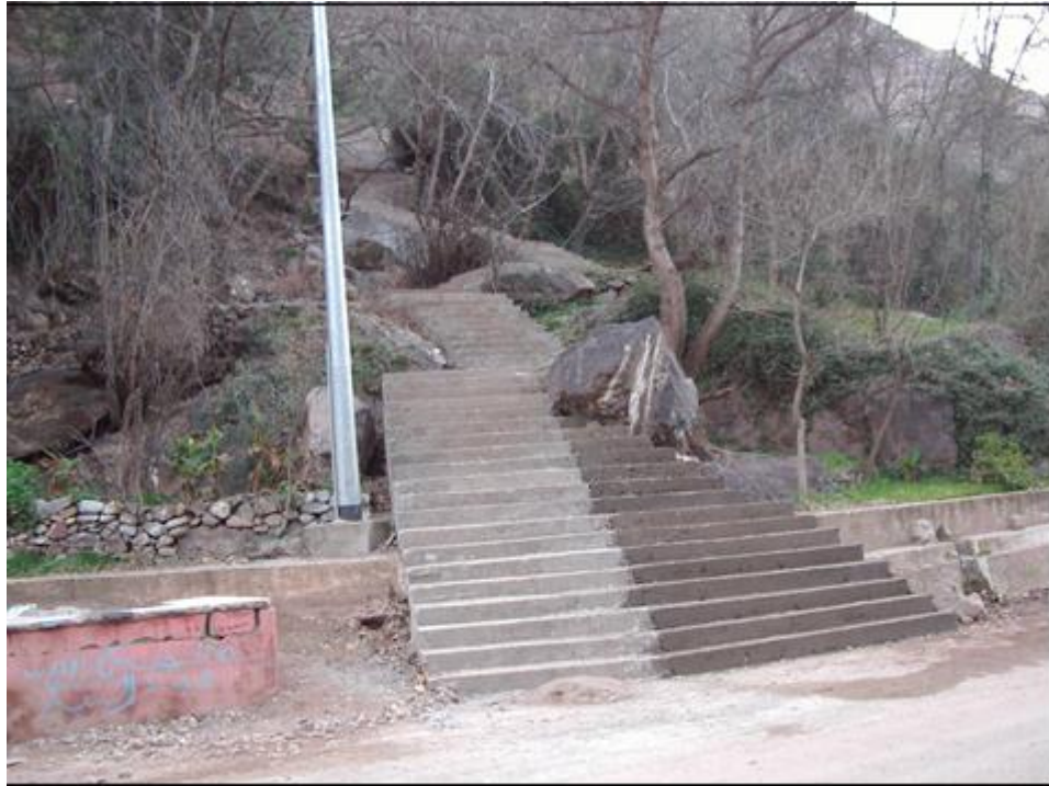
Figure 21: escaliers de secours construits dans la vallée dans le cadre du projet Ourika, Oulmès (DREF,2010)
