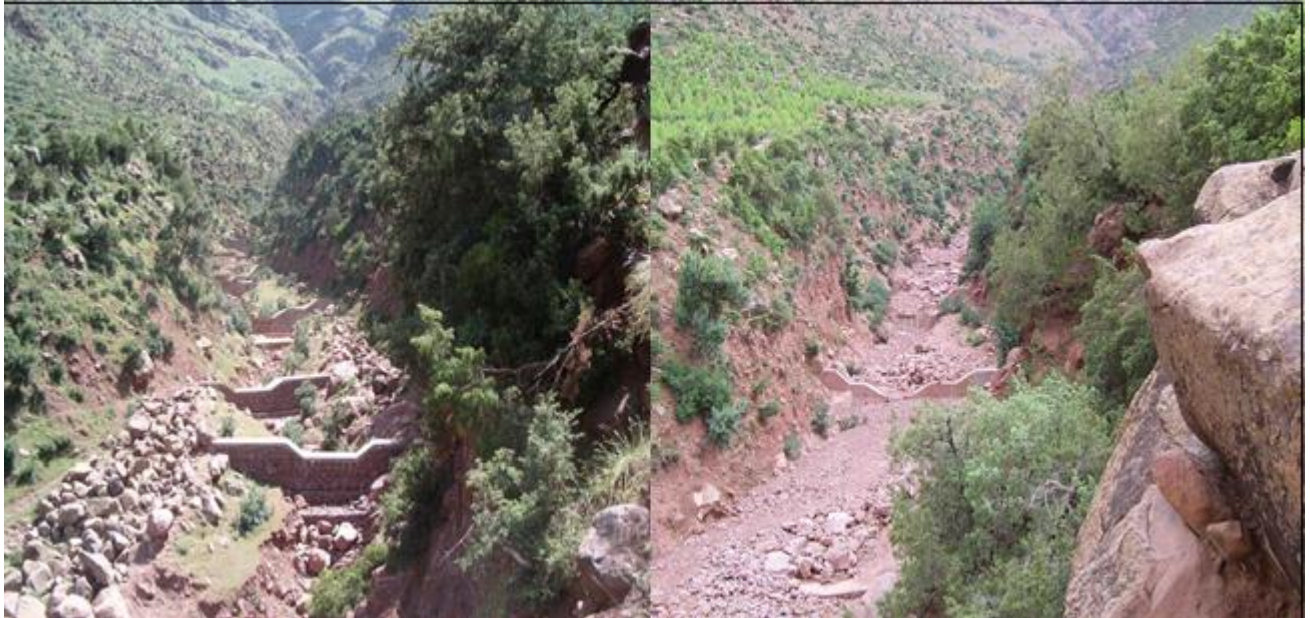
Figure 20: vue en aval du ravin ighrman corrigé mécaniquement (DREF ,2010)
