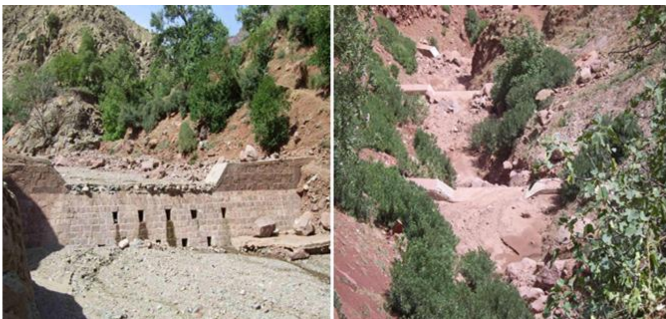
Figure 18: seuils en maçonnerie (DREF, 2010)
