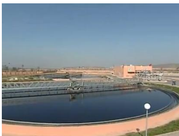
Décanteur secondaire "clarificateur"
