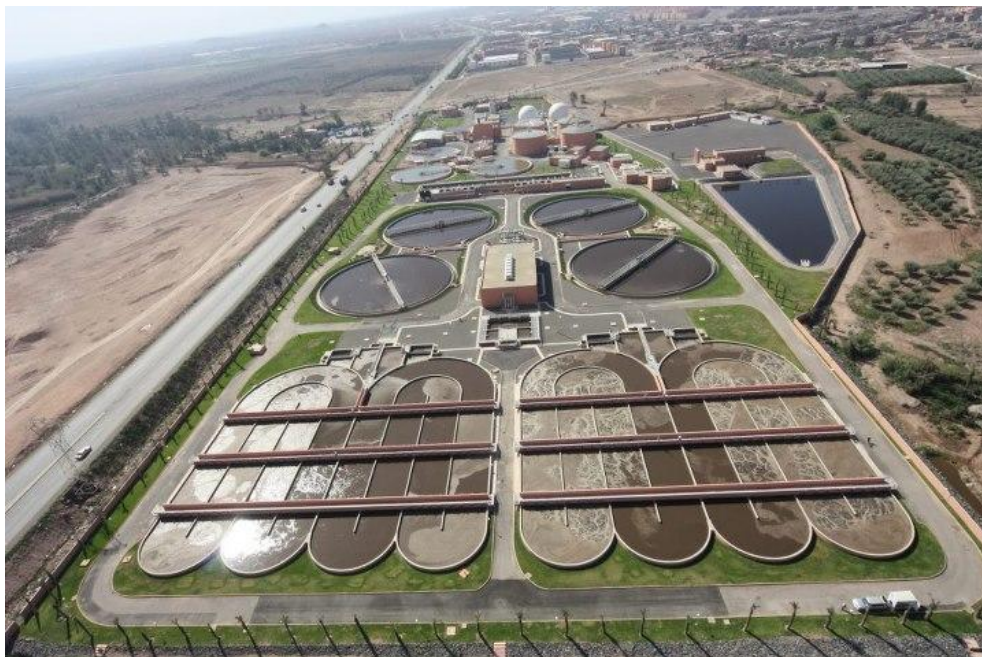
Photo.1 : station d'épuration de la ville de Marrakech
