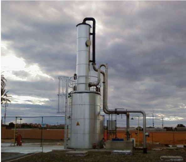
Mécanisme de désulfuration
