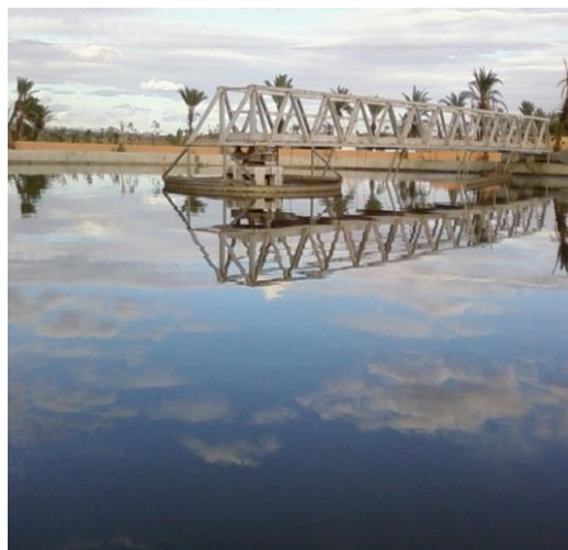
Photos 5 : décanteur primaire.
