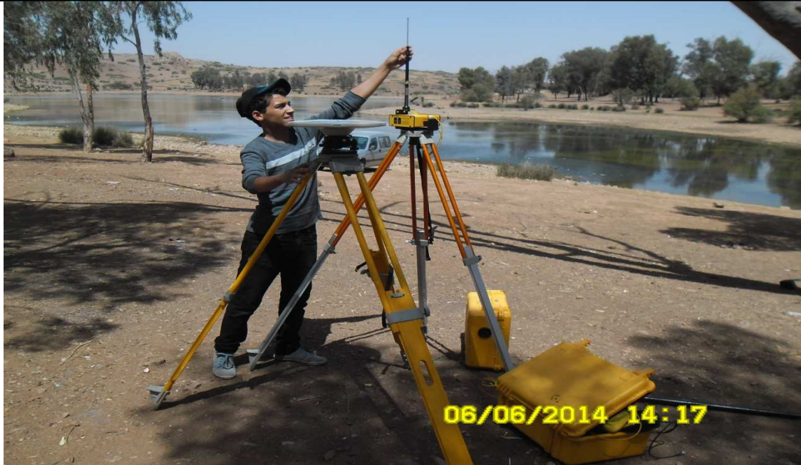
Figure 20 : Installation du GPS, Base fixe
