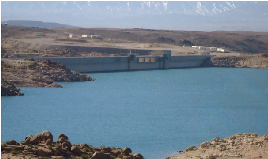
Figure 18 : photo du Barrage Hassan II, Haute Moulouya (Février 2013).
