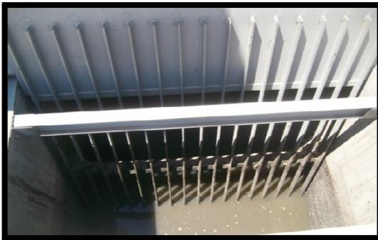
**Fig.4: dégrillage fin (10cm)**
