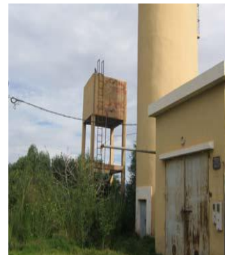
Photo 7 : Réservoir de 10 m 3
