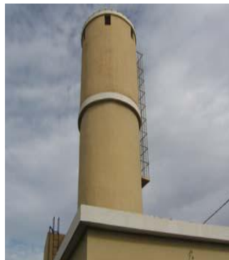
Photo 6 : Réservoir de 50 m 3
