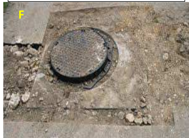
Fig. 6: A- Exemple de ventouse, B-Vanne, C- Modèle de stabilisateur utilisé dans le réseau de distribution d'eau, D- Exemple de modulateur utilisé pour compensation des pertes de charge d'eau, E- Modèle de bouche d'incendie, F-Regard d'eau potable sur la route.
