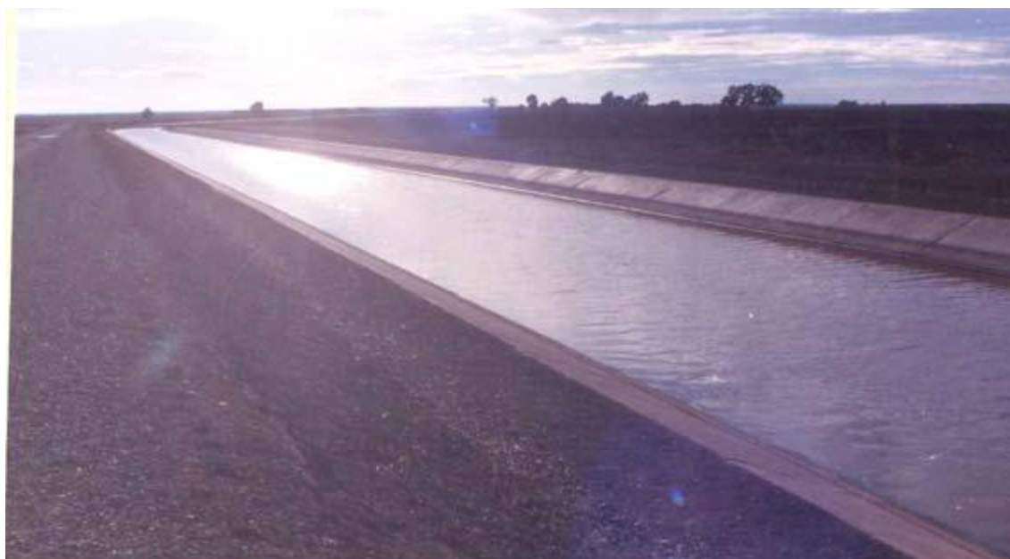
Photo.1 Canal de Rocade
