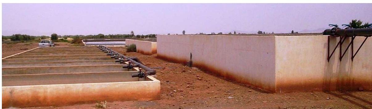
Les lits de séchage de boues Bassin de dessablement Photo 17 : le bassin de dessablement et les lits de séchage à l'extension de la station.
