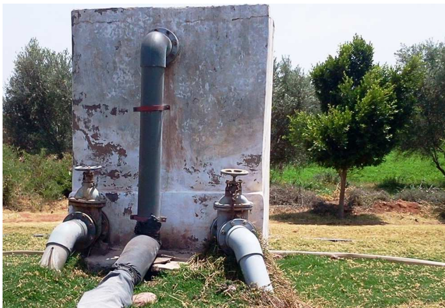
Photo11: Bassin de Dissipation sortis de l'eau
