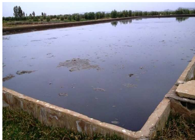
Photo24 bassin de maturation (M1).
