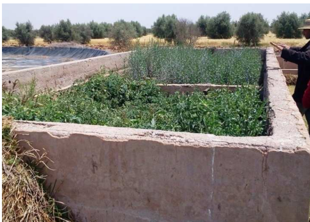
Photo 15 : Décanteur de la station actuelle (hors de fonctionnement).
