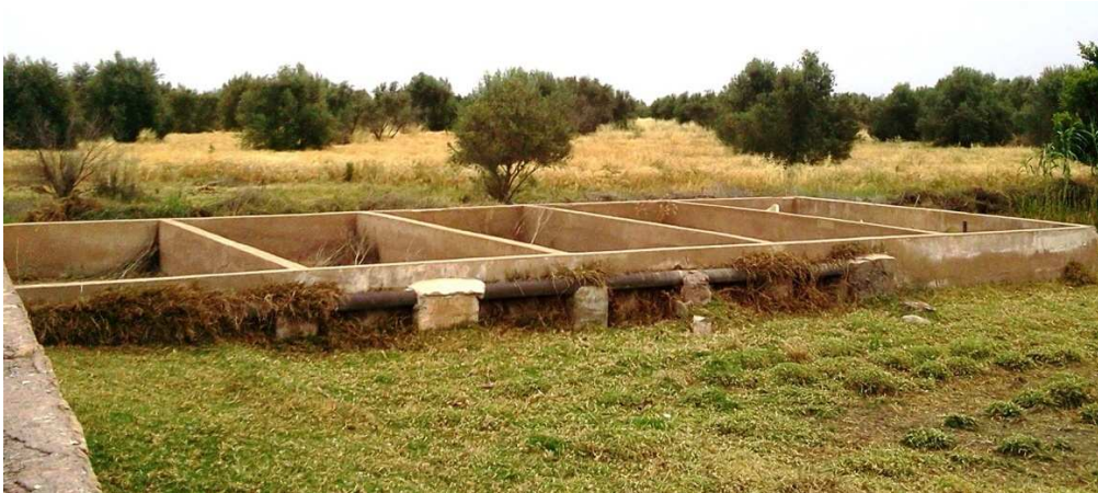
Photo 19 : Lits de séchage de la station actuelle
