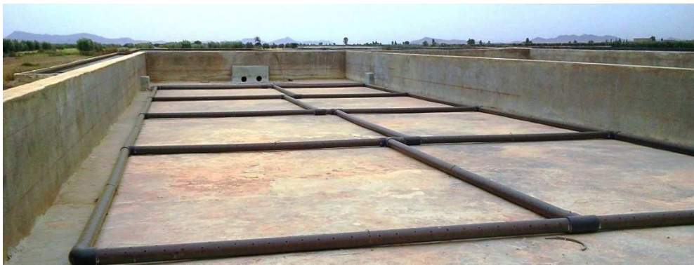
Photo 23 : Bassins de maturation au cours de construction
