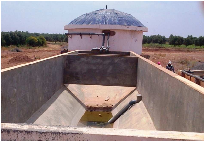
Photo 16 : Décanteur de l'extension de la station
