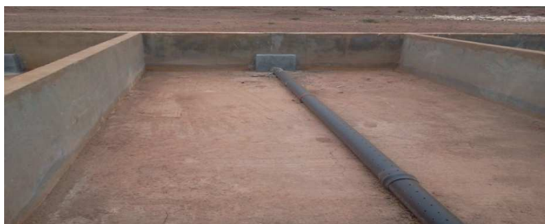
Photo 18 : Lit de séchage de boue au cours de construction a la nouvelle station.
