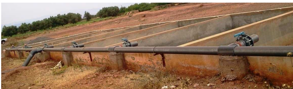
Photo 20 : Lits de séchage de l'extension
