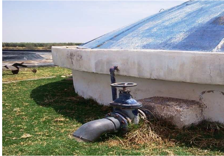
Photo 14 : Dispositifs d'entrée des Réacteurs
