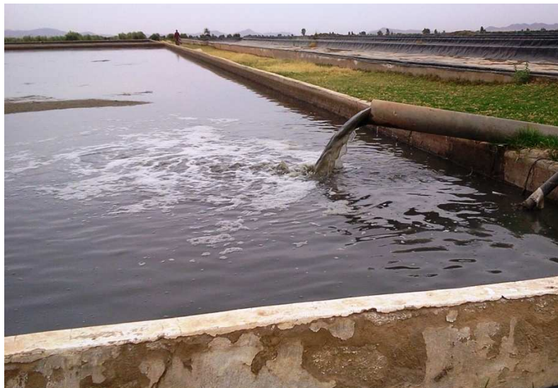
Photo 25: bassin de maturation (Dispositifs d'entrées et Sorties) (BM1)
