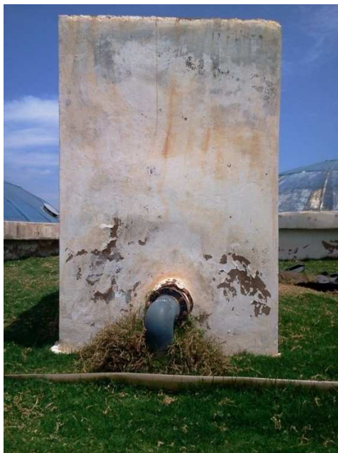
Photo10 : L'entrée de l'eau au bassin de la dissipation
