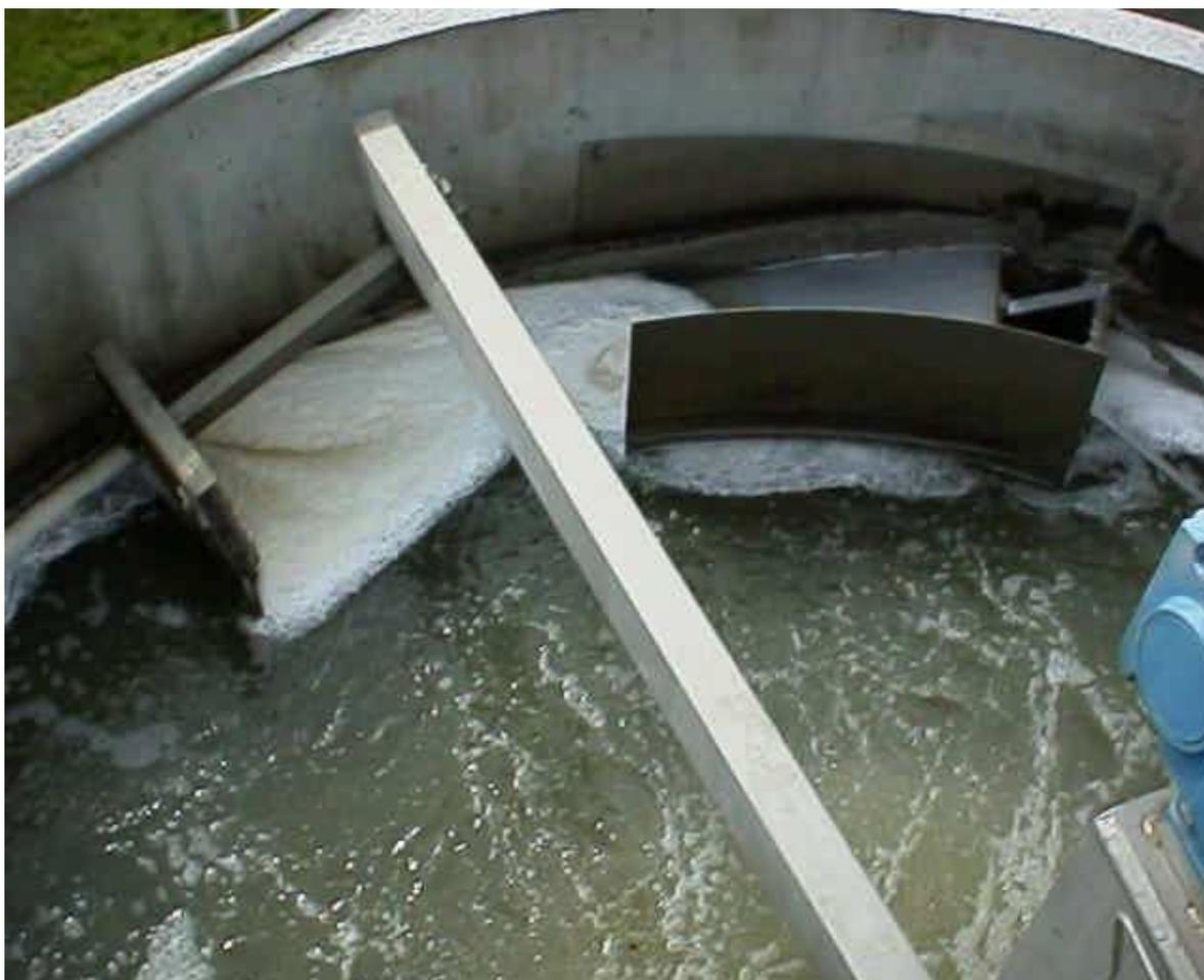
**Photo 3 : Raclage des graisses d'un dégraisseur**
