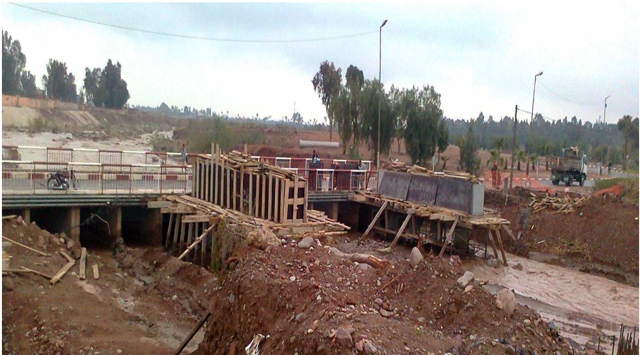
Photo 8 : Travaux de construction d'un pont élevé sur l'oued Issil à Marrakech
