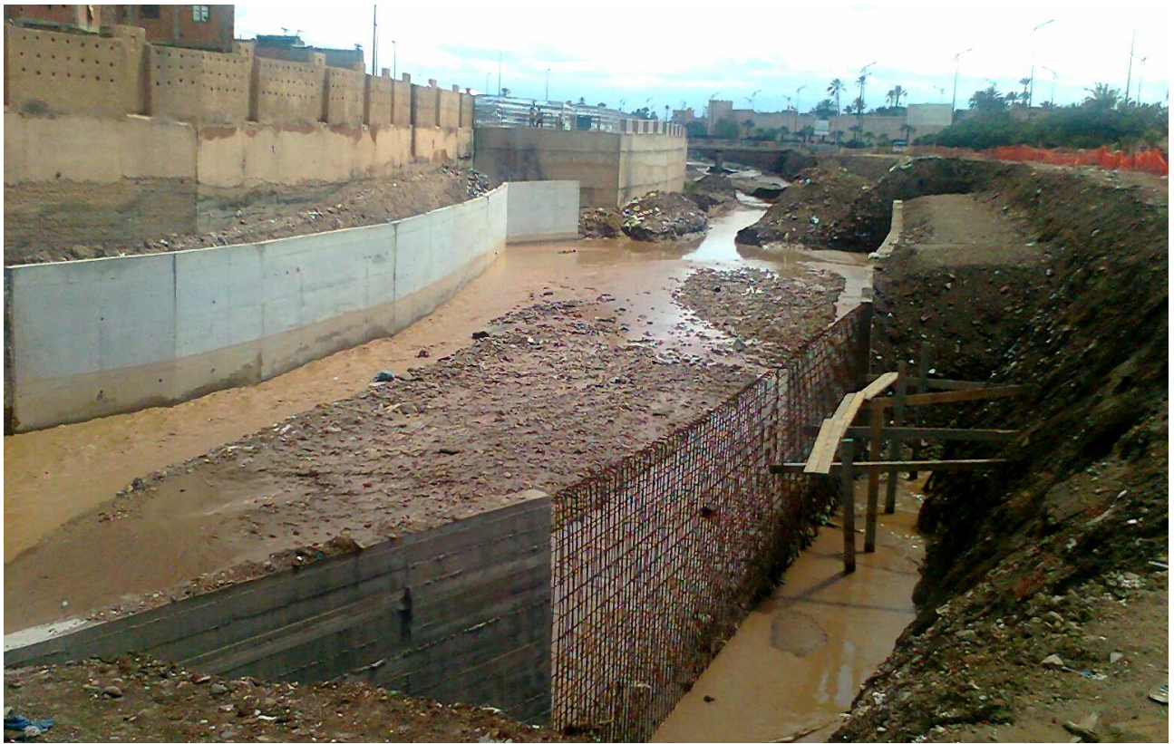
Photo 9 : Travaux de construction de murs de protection et de renforcement des berges de l'oued
