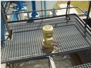
**N.B. :** Le mélange entre les réactifs et l'eau est assuré par un mélangeur rapide afin d'augmenter la surface de contact entre les deux.
