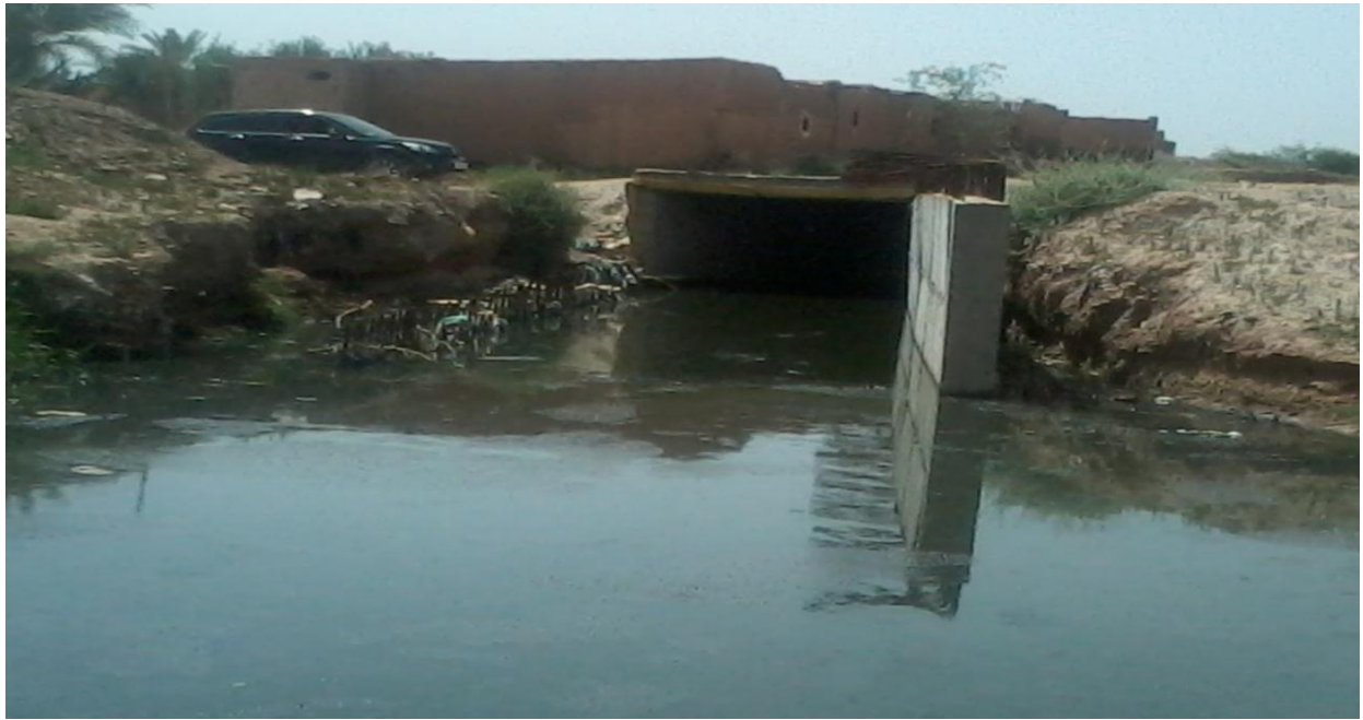
Figure 22 : Débordement des rejets des eaux usées domestiques vers l'Oued Tensift (mai, 2014).
