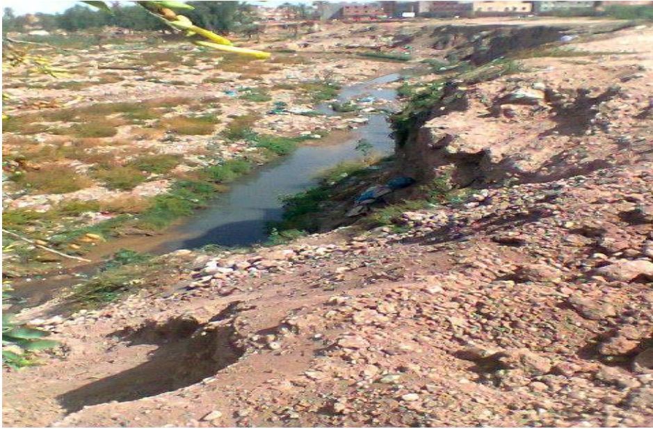
Figure 10 : Rejet des eaux usées du Club Med dans l'Oued Issil.
