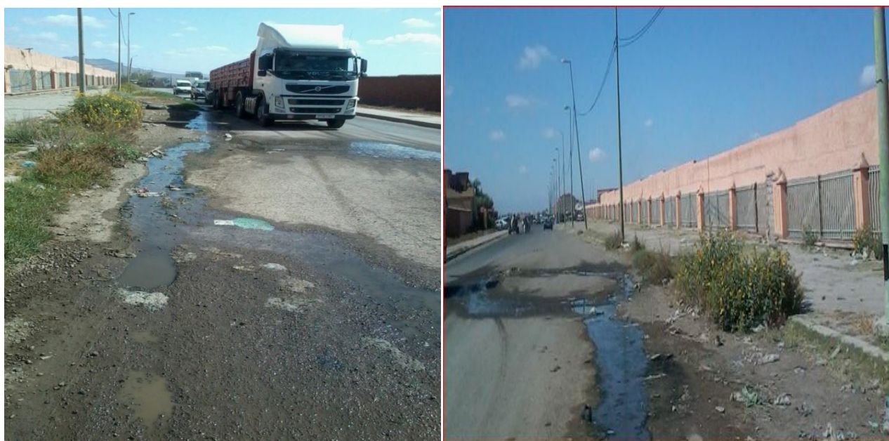
Figure 19 : Débordement des rejets des eaux usées dans la rue lotissement Al Massar (mai, 2014).
