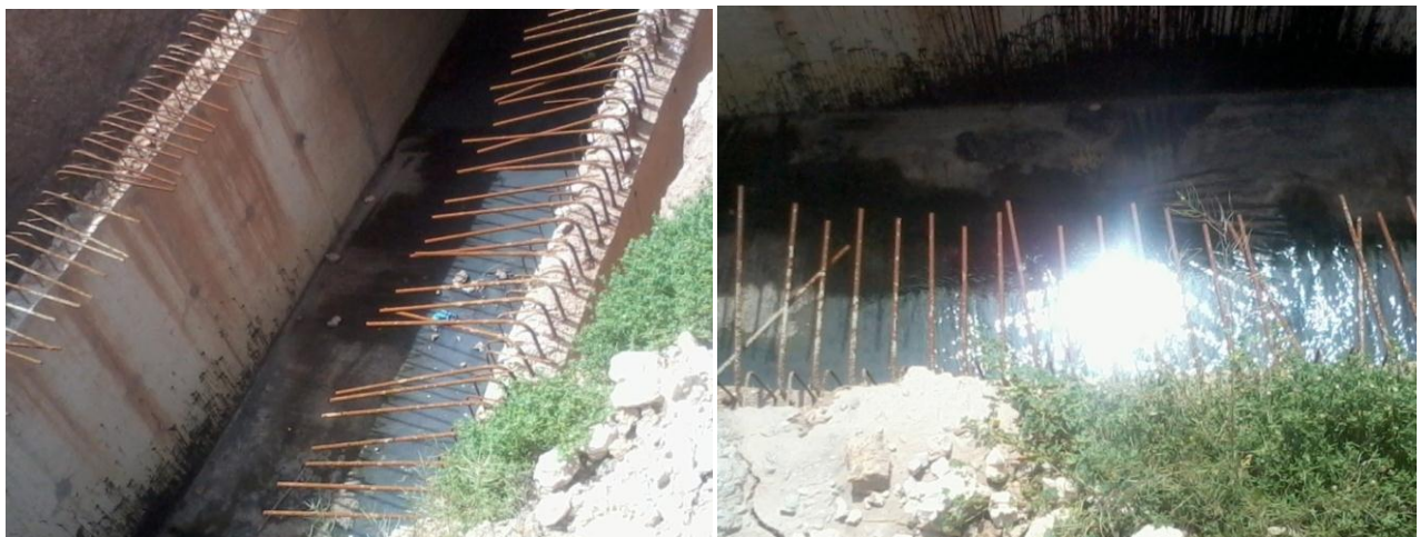
Figure 21 : Rejets des eaux usées domestique au long du dalot à temps sec (mai, 2014).
