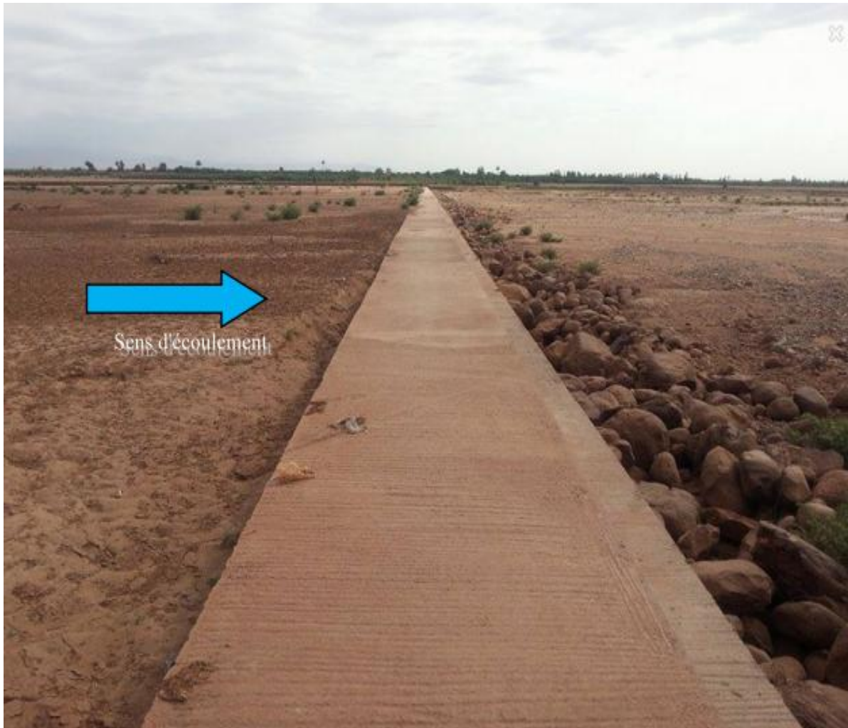
Photo 3 : le colmatage du bassin d'infiltration au niveau du seuil 8.
