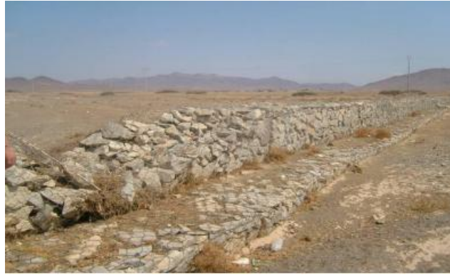
Photo 2 : Seuil en gabion
