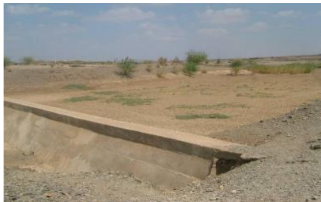
Photo1 : Seuil en béton
