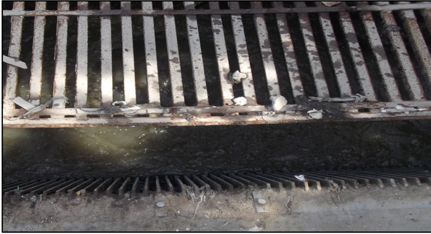
Photo 1 : Le dégrilleur du prétraitement
