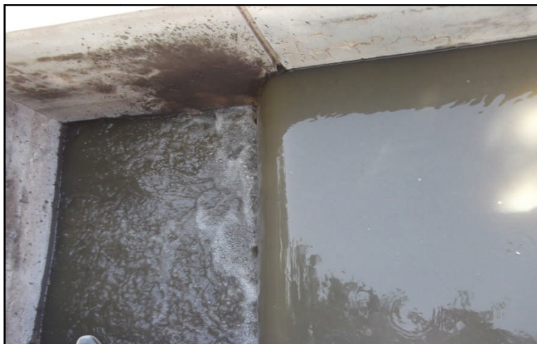
Phot 2 : L'ouvrage de du dessablage
