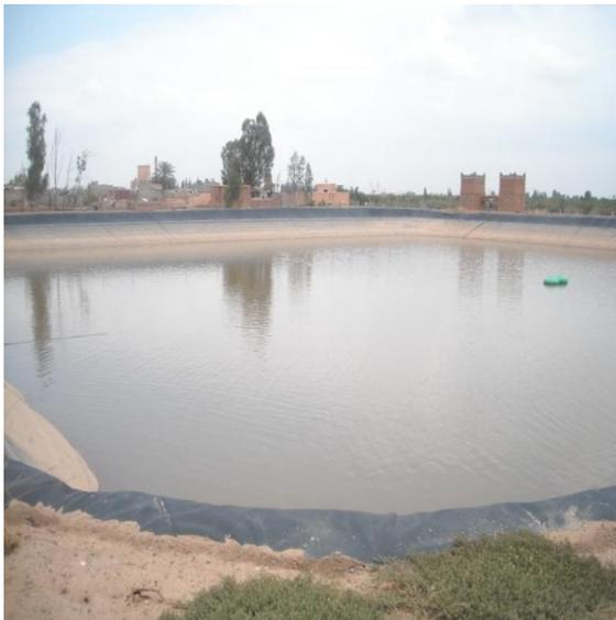
Bassin d'accumulation couvert d'une géomembrane
