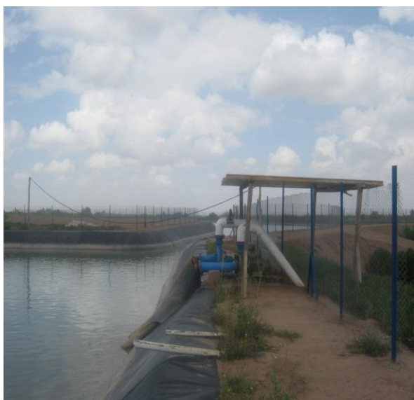
Photo. 5 : Système de pompage installé au niveau d'un bassin de décantation (domaine Bahja, secteur N1-4).
