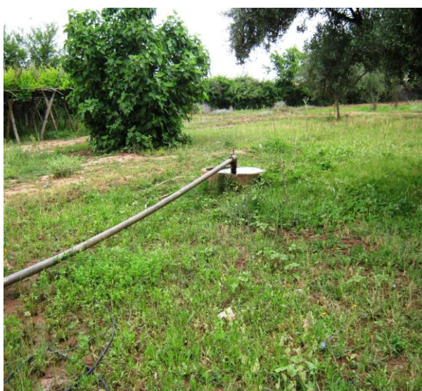
Photo. 1 : Une prise installée en tête d'une parcelle au niveau du secteur N1-2.
