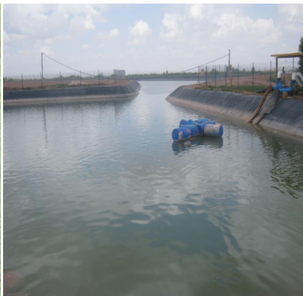
Photo. 4 : Un bassin de décantation où se mélange les eaux aductées par les bornes de l'ORMVAH dans le domaine Bahja secteur N1-4 .
