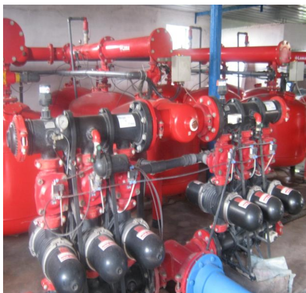
Photo. 6 : Filtre à disque installée en avant du système de pompage (domaine Bahja, secteur N1-4)
