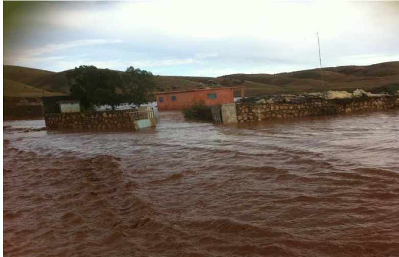
Photo.1 : Inondation des locaux de la station de Talkest sur l'oued Tensift (ABHT, 2014)
