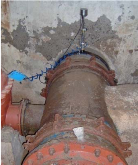
Débitmètre à insertion installé sur DN800 AC (HD1)
