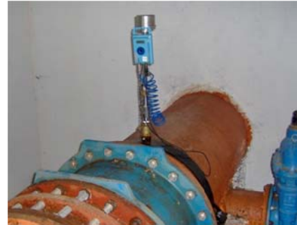
Débitmètre à insertion installé sur DN800 BP (HD2)
