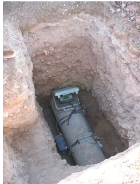
Débitmètre à insertion installé sur DN800 BP (HD2)
