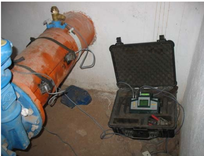
Débitmètre à Ultrason installé sur DN500 AC vers Medina Sud (HD5)
