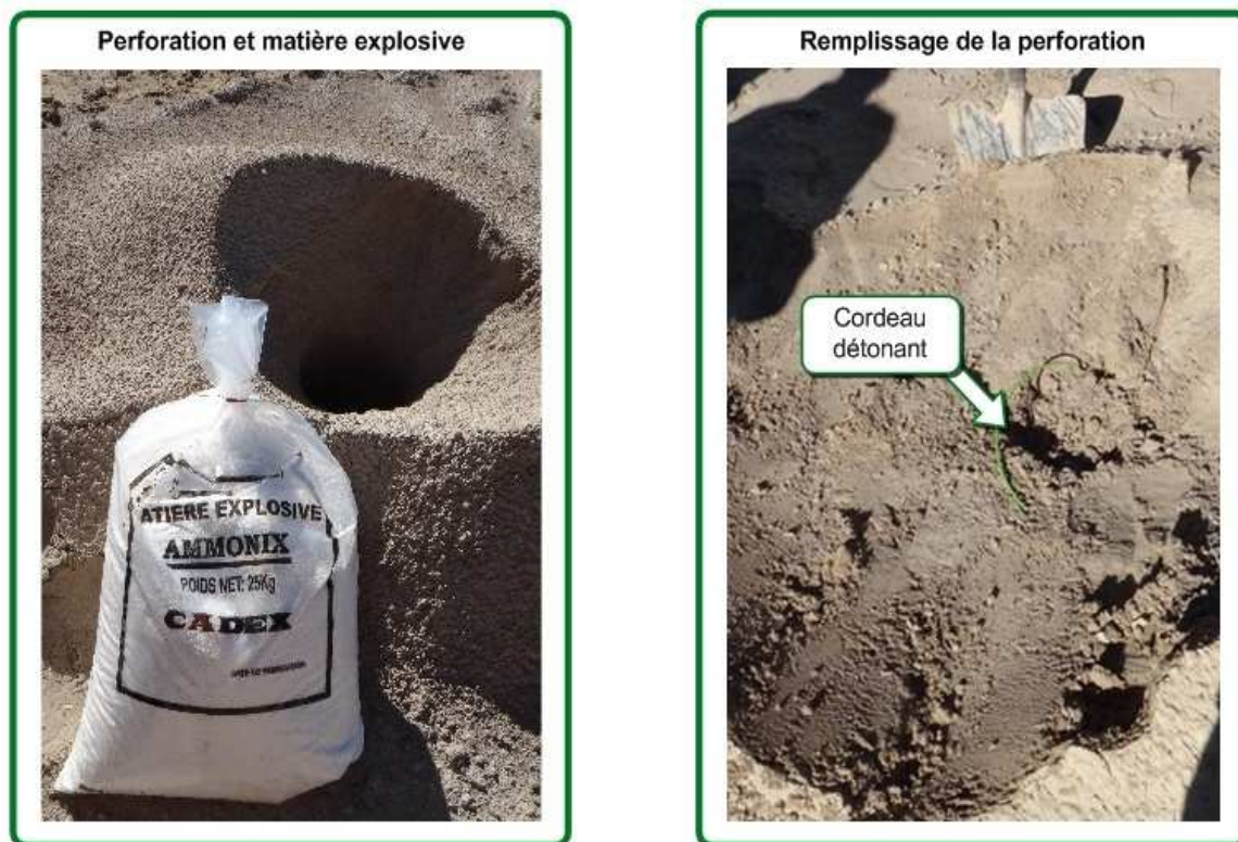
Fig. 8: photos montrant le remplissage de la perforation par la matière explosive.
