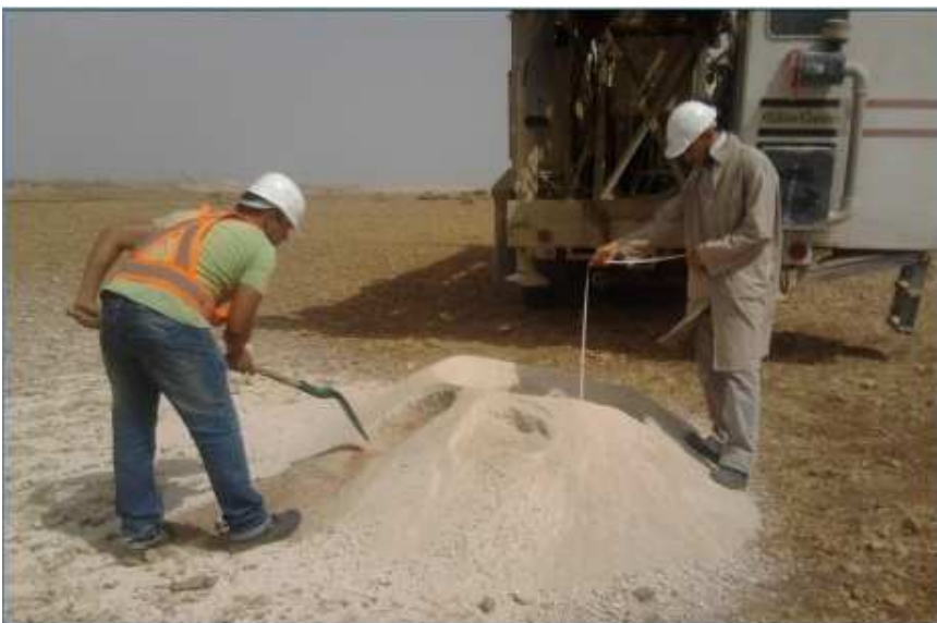
Fig. 23: Cuttings d'un sondage.
