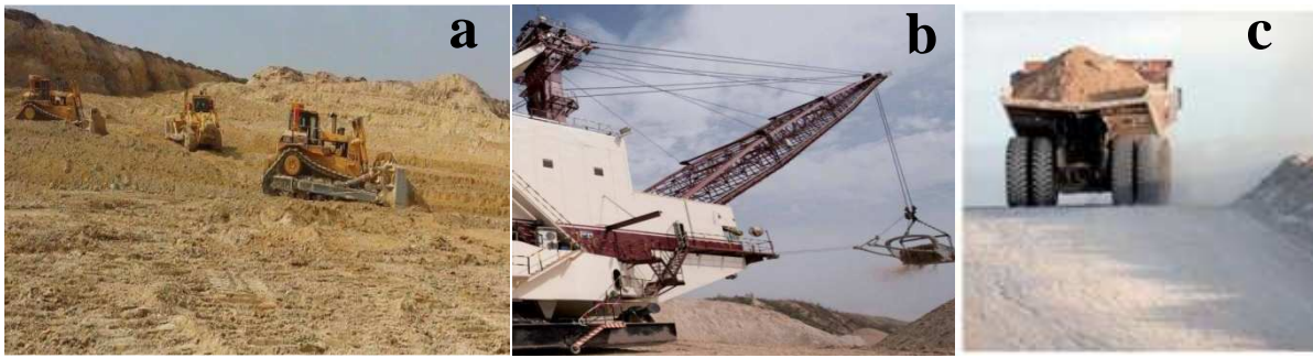
Fig. 9 : a- Décapage par poussage, b- Décapage par casement c- Décapage par transport
