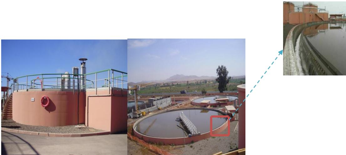
**Photo 6 : Photo du Répartiteur (à gauche), décanteur (à droite)**
