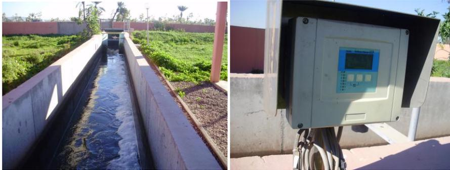
**Photo7 : Photo du Canal venturi (à gauche), débitmètre (à droite).**
