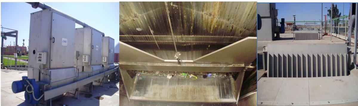
**Photo 3 : Grille automatique (à gauche), Grille manuelle (à droite)**
