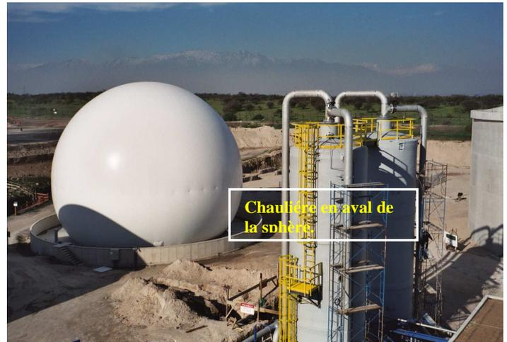
**gazomètre avec une unité de biodésulfurisation en aval**
