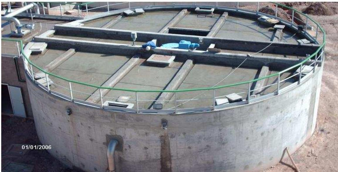
Photo5 : Epaisseurs Degrémont - Bogotazo (Colombie, 1 500 000 eq/h) 2 unités de 29 m de diamètre.
