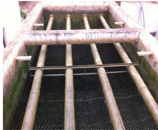
Photo4 : décanteur lamellaire vide (lavage)
