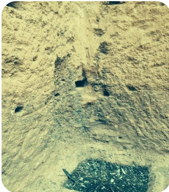
**Figure 7 : Dégradation de la base du mur dû aux agressions humaines**
