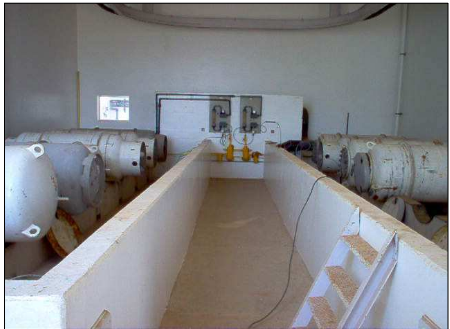
Photo 12 : Les tanks de chlore en gaz
