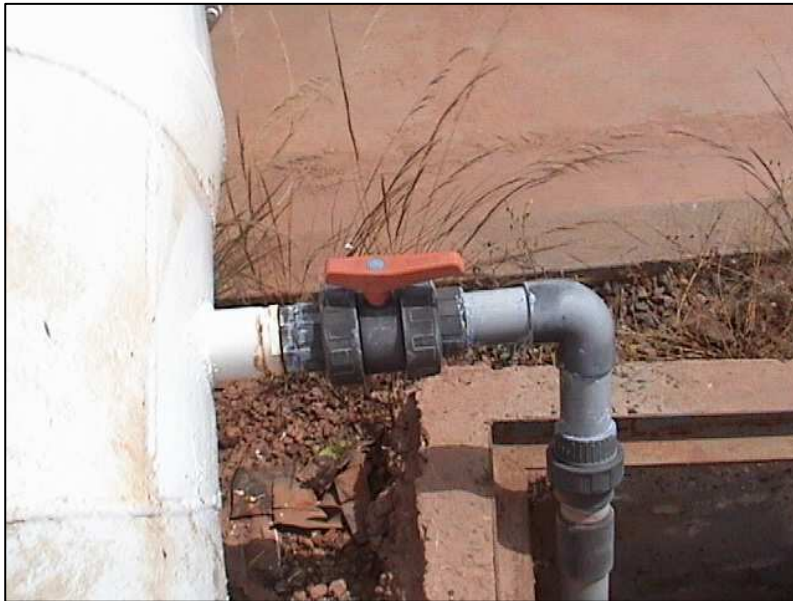
Photo 4 : L'injection du chlore
