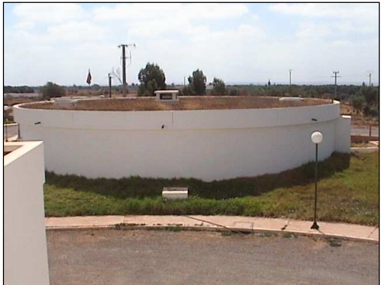
Photo 13: Réservoir 1500m 3
