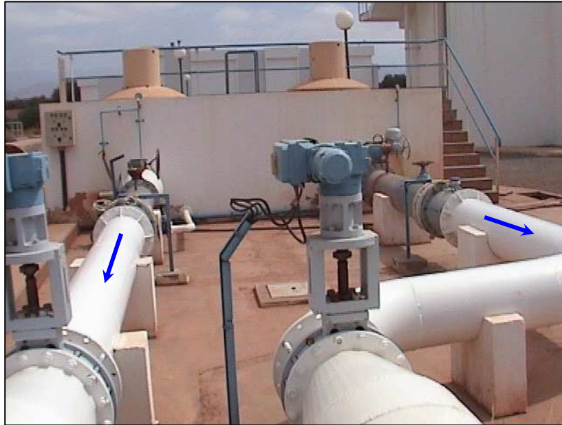
Photo n° 2 : vue des deux conduites assurant l'entrée de l'eau brute dans la station
