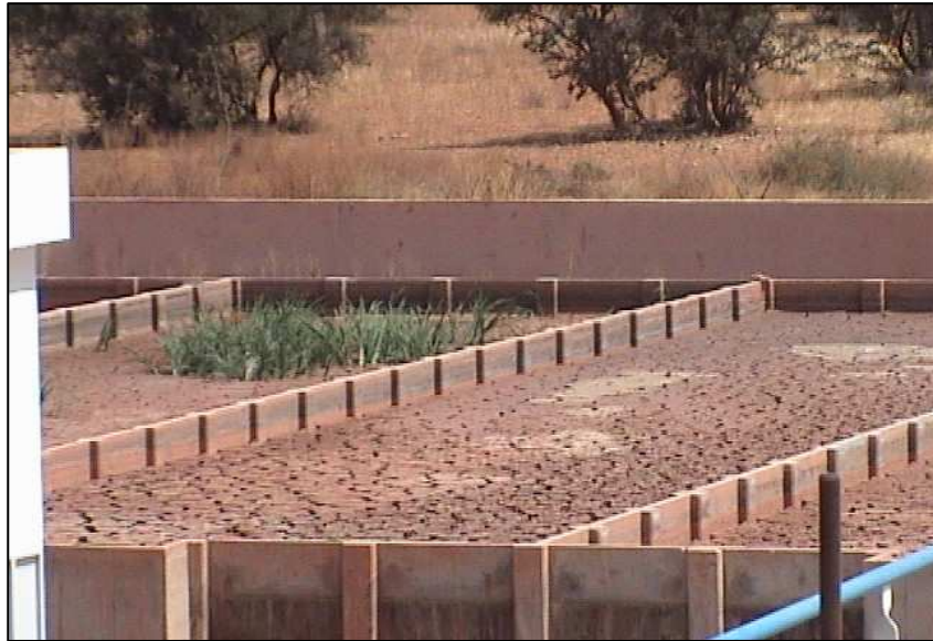
Photo n°15: Les lits de séchage
