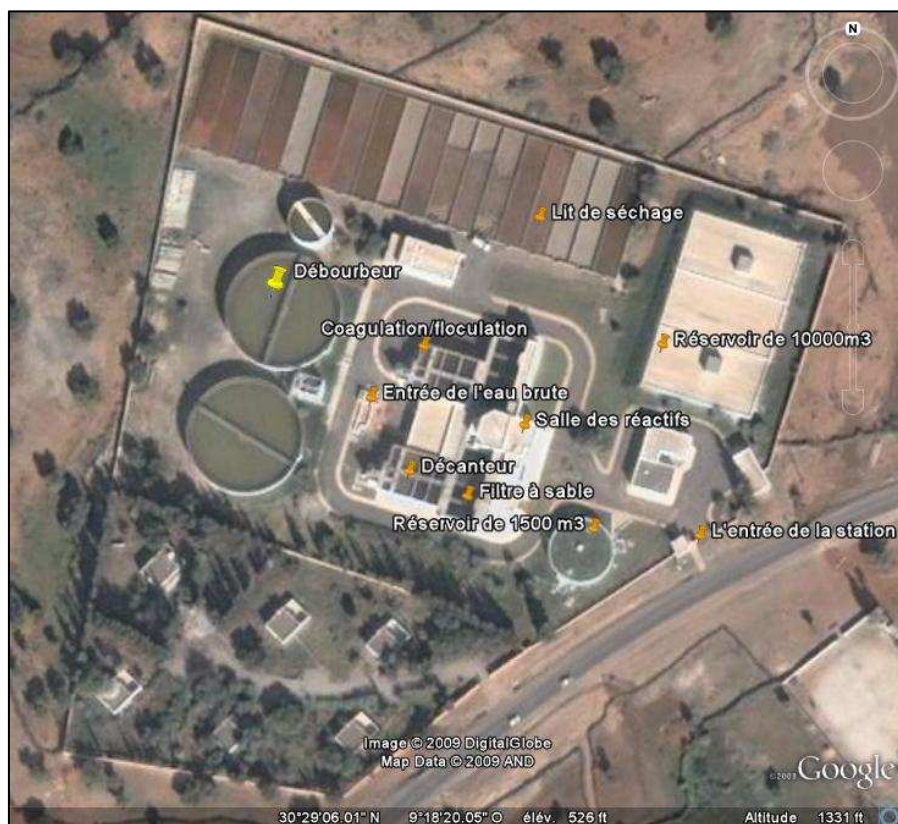
Photo n°1 : Vue aérienne de la station Sidi Boushab
