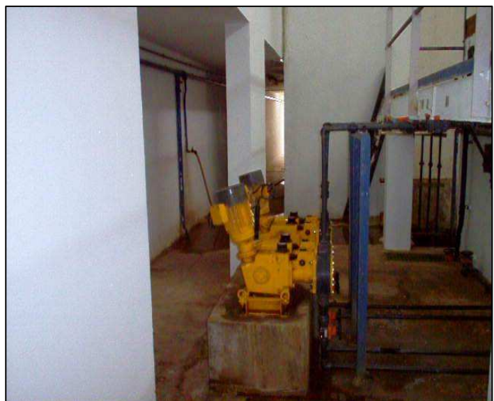
Photo 7: Pompe de sulfate d'alumine
